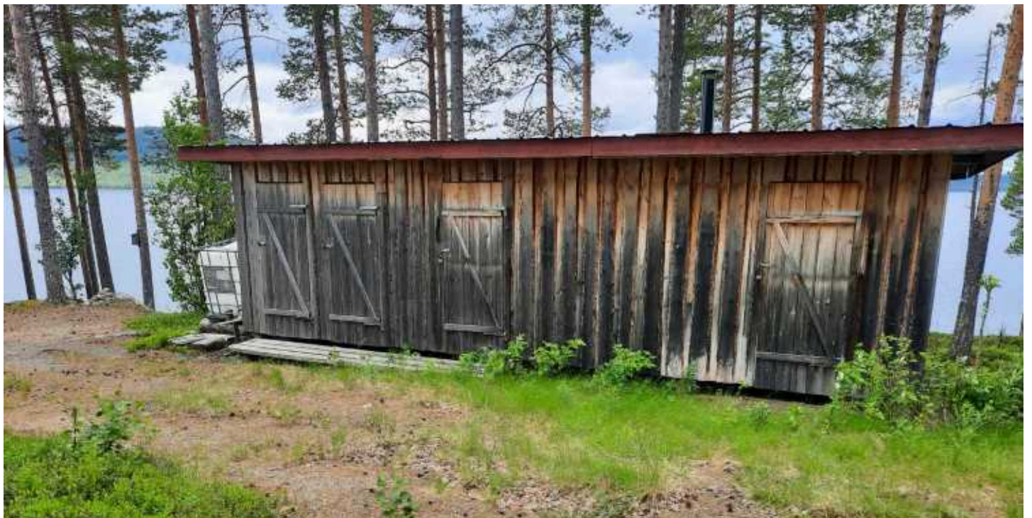
Förrådsbyggnad inrymmandes utedass/vedeldad bastu samt redskapsbod.
